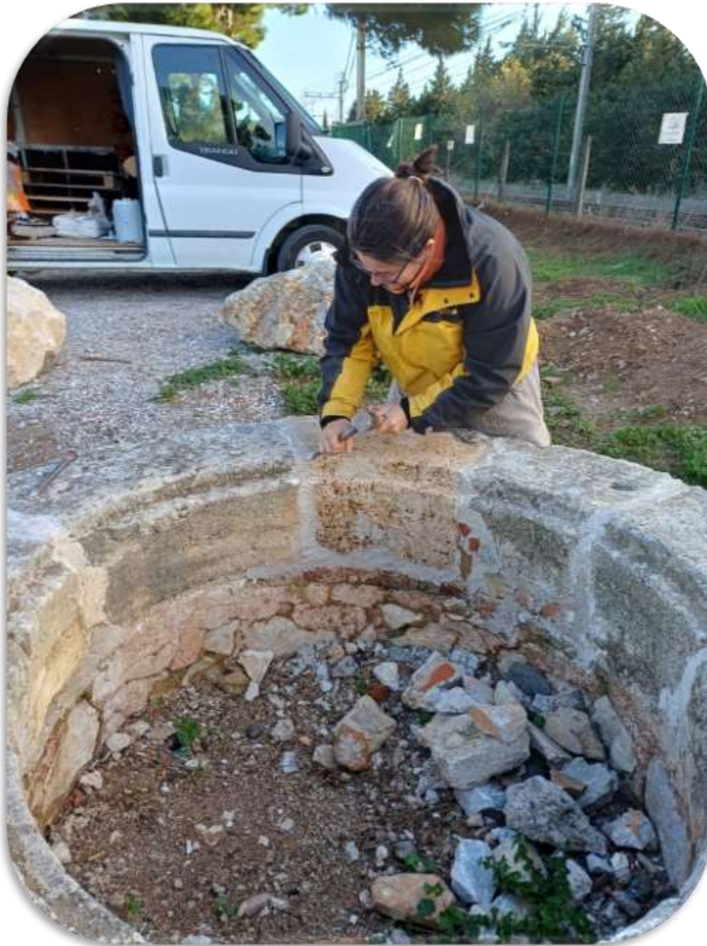
Flo reprend les joints de la pierre mise en place il y a dix jours
